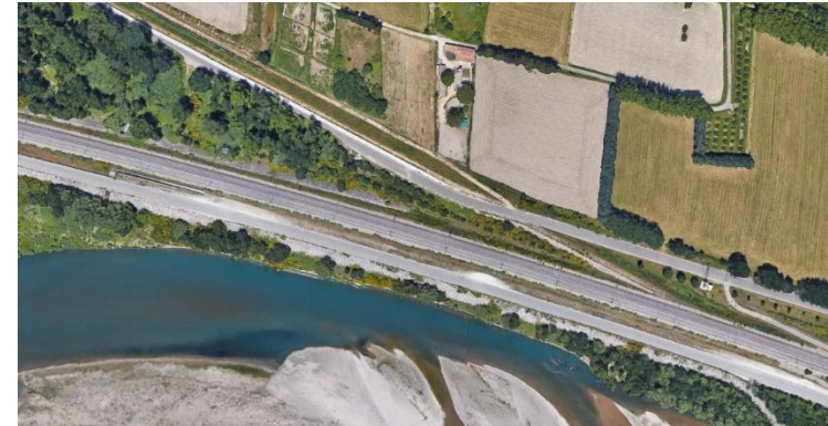
Rive de la Durance longée par les infrastructures
