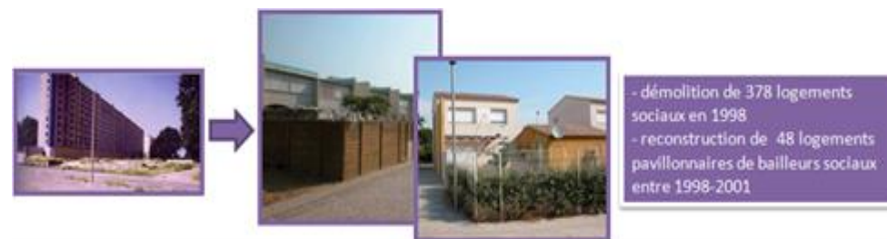
Opération de démolition/reconstruction sur le secteur de la Croix des Oiseaux (secteur de la Rode)
