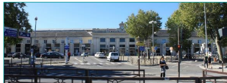
Photo : La gare d'Avignon Centre
