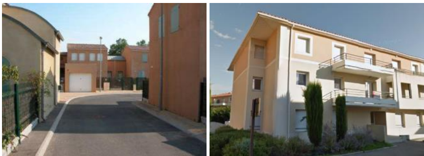
Nouveaux programmes d'habitat sur les sites de Champfleury sur à la démolition des barres en 1987 et 1993
