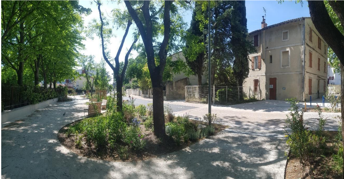
Travaux de réhabilitation de l'Avenue Moulin Notre Dame (1,3 M€ en 2022 ; coût prévisionnel de l'opération : 4,42 M€)
